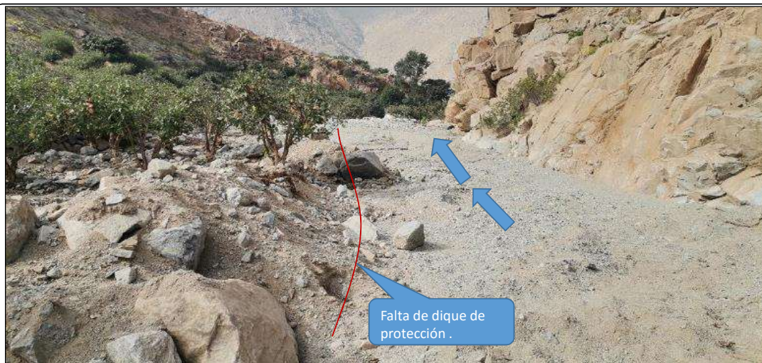
FIGURA N°06: TRAMO DEL RÍO CHANCAY - HUARAL EN LA MARGEN IZQUIERDA SIN PROTECCIÓN ANTE EL FLUJO DEL RÍO, OCASIONA INUNDACIONES EN CAMPOS AGRÍCOLAS UBICADAS EN ZONAS ALEDAÑAS.
