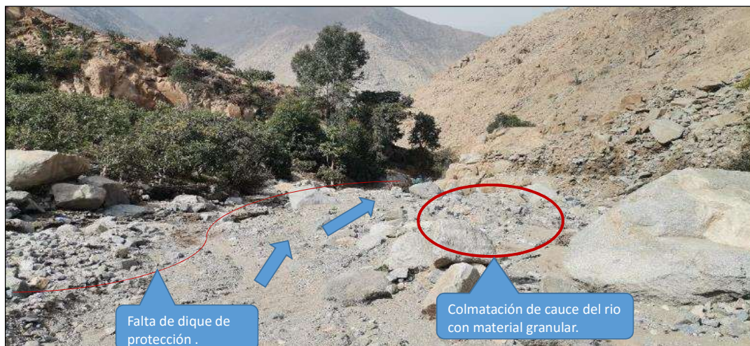
FIGURA N°04: REDUCCIÓN DE LA SECCIÓN HIDRÁULICA DEL RÍO CHANCAY - HUARAL EN EL SECTOR SAN MIGUEL, OCASIONA DESBORDAMIENTO DEL CAUCE A ZONAS ALEDAÑAS.
