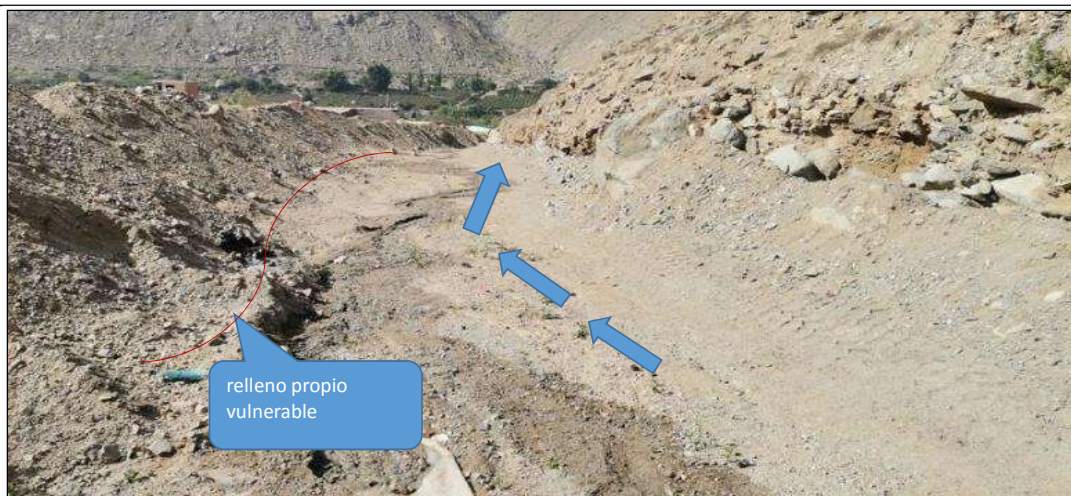
FIGURA N°02: TRAMO DEL CAUCE DEL RIO CHANCAY - HUARAL CON DIQUE DE MATERIAL PROPIO EN MAL ESTADO, EN EL SECTOR SAN MIGUEL DEL DISTRITO DE HUARAL.
