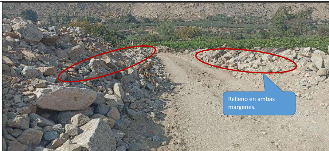
FIGURA N°01: RIO CHANCAY - HUARAL CON DIQUE DE PROTECCIÓN VULNERABLE EN AMBAS MÁRGENES EN EL SECTOR SAN MIGUEL.
